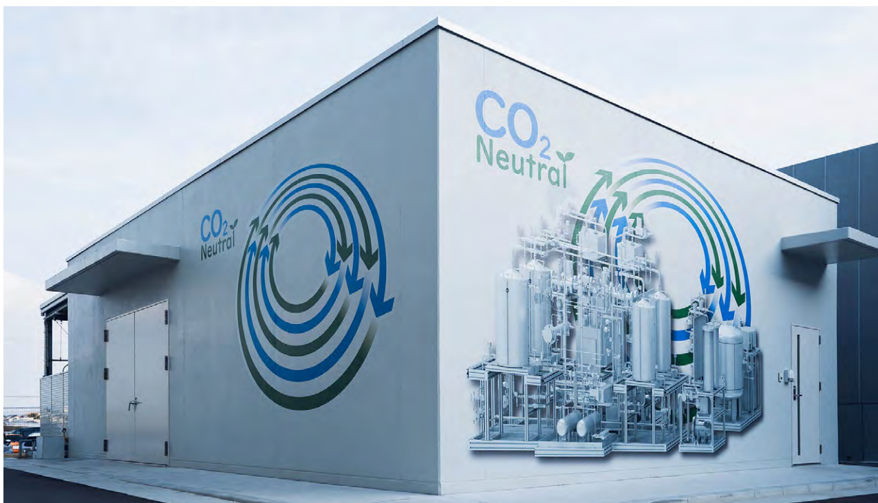
愛知県の安城製作所に併設されたCO 2 循環プラント。株式会社豊田中央研究所と共同で技術を開発して完成
