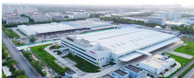
天津電装電機有限公司(TDS)
