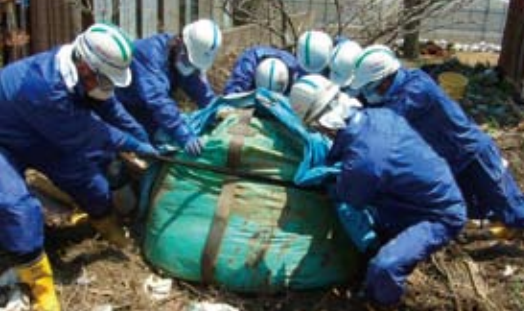
被災地で復旧作業にあたる社員
