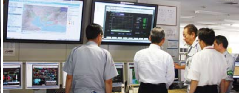
緊急節電訓練で対象機器を確認
