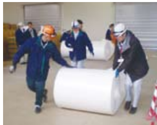
夜間の冷気に備えて断熱シートを敷設
