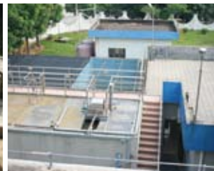
生活系排水の浄化処理施設(DMGZ)
