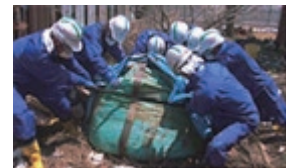
東日本大震災の被災地で 復旧作業にあたる社員
